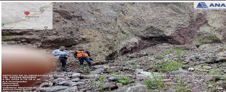
FIGURA N° 01: TRAMO CRÍTICO ZONA PELIGROSA POR DERRUMBE EROSIONADO MARGEN DERECHA EN QUEBRADA PAYHUA, SECTOR PAYHUA, DISTRITO DE MATUCANA, PROVINCIA DE HUARACHIRI, DEPARTAMENTO DE LIMA
